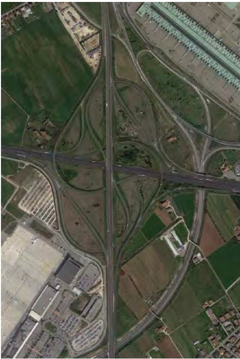
Svincolo direzionale A4 – A22 Verona (530.000 m 2 di sedime)
