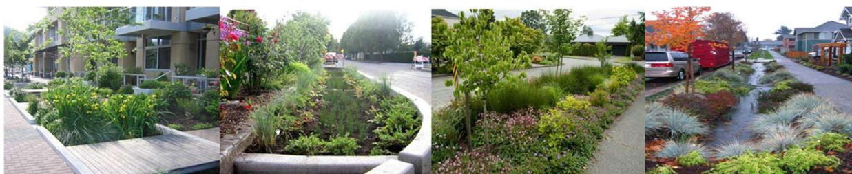
I progetti dei Centri di Mobilità dovranno inoltre prevedere l'impiego di pavimentazioni permeabili e drenanti (sistemi di pavimentazione a griglia aperta, superfici verdi, ecc.) soprattutto nelle aree destinate a pedoni e ciclisti (con superficie a basso indice di riflettanza solare SRI) e nei parcheggi pubblici e piazzali, in particolare per ridurre lo scorrimento superficiale delle acque dovuto a fenomeni di pioggia particolarmente intensi.
