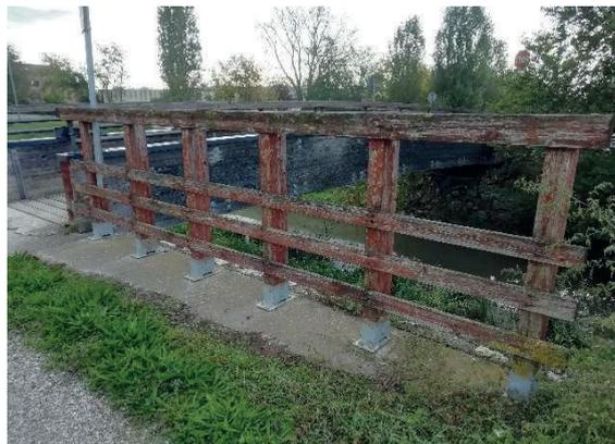
**Stato parapetti:** da mantenere (133 cm, di cui 82,5 cm di spalla in legno)
