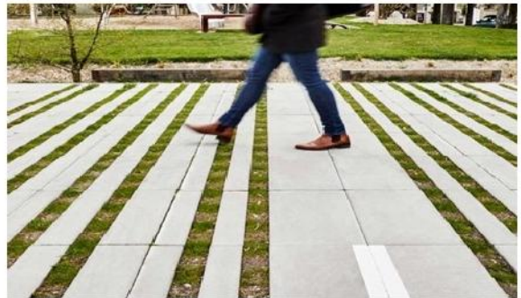
Esempio costruttivo di marciapiede permeabile
