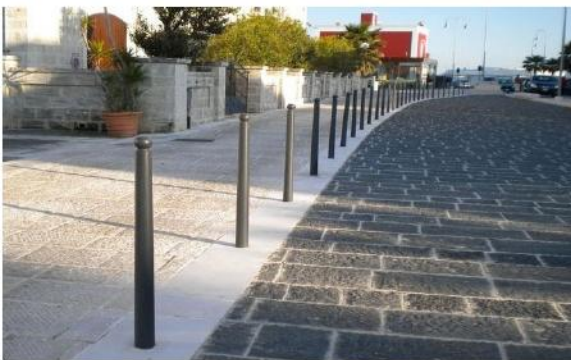
Delimitazione tra carreggiata e percorso pedonale
