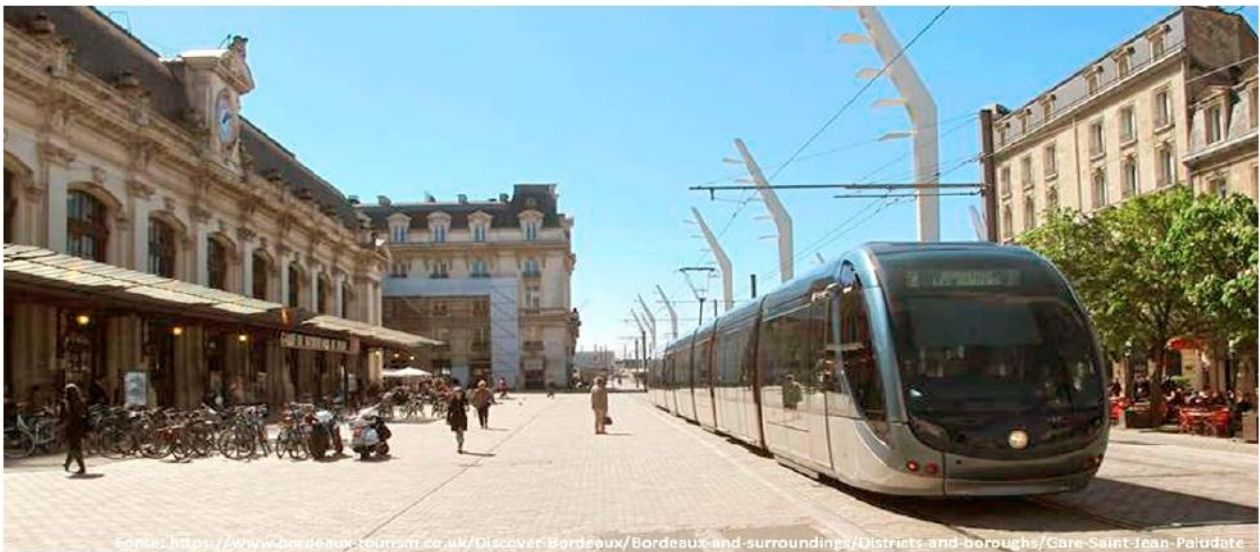
Continuità e qualità della sede stradale in corrispondenza del tracciato del tram - Bordeaux (Francia)
