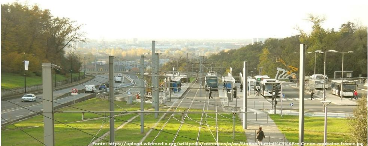
Stazione intermodale bus-tram con pavimentazione dedicata a prato permeabile - Cenon (Francia)
