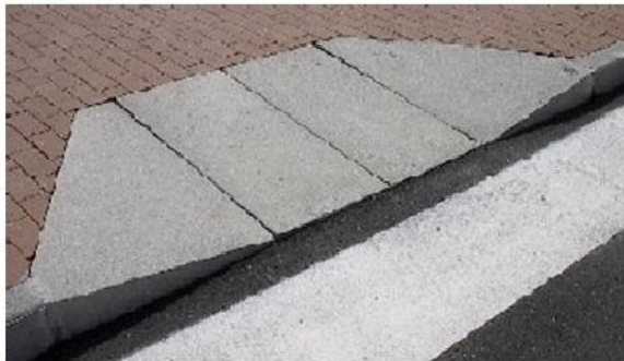
Esempio costruttivo di scivolo per mobilità leggera
