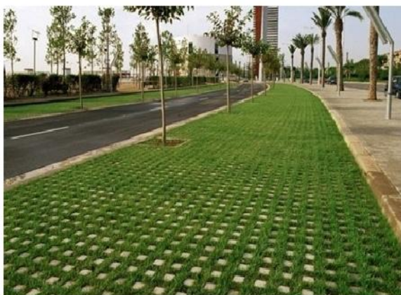
Esempio costruttivo di parcheggi permeabili
