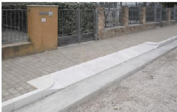
Esempio costruttivo di scivolo per mobilità pesante
