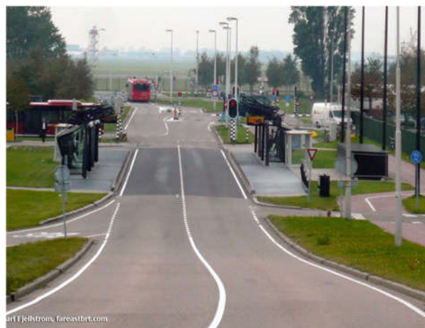
Figura 6—8: : esempio di sede segregata con intersezione con la rete stradale ordinaria– particolare del punto di intersezione (Amsterdam - credit to: Karl Fjellstrom, Far East Mobility )
